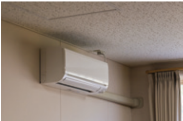
保育所乳幼児室空調設備設置 660,000円
