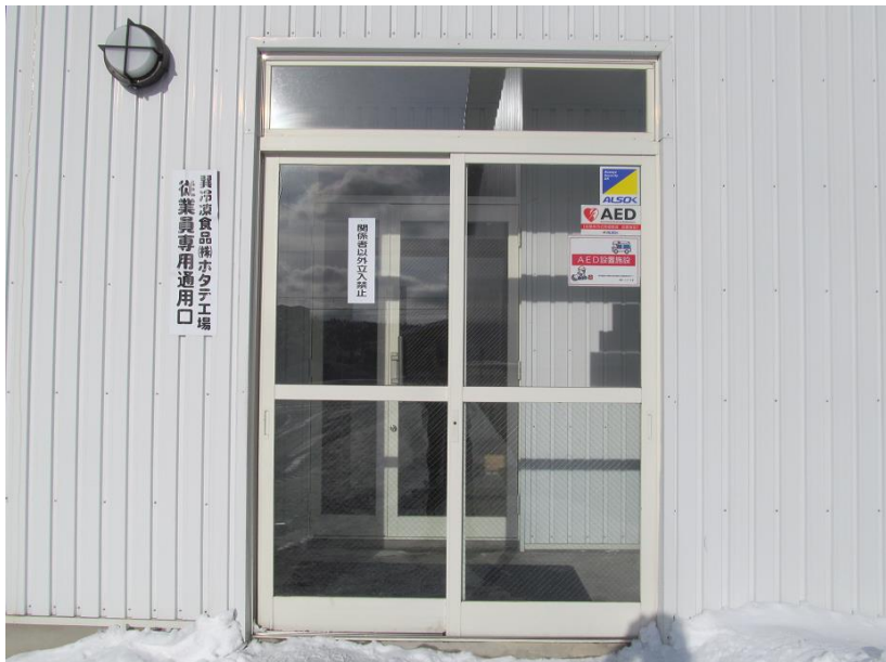
工場 左側・従業員専用通用口
