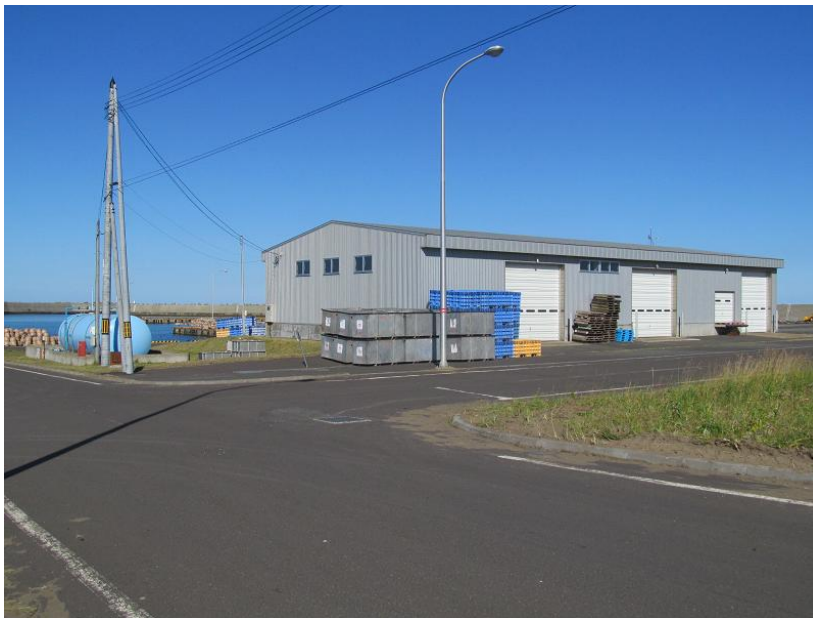
浜猿払 漁業協同組合 荷捌所（全景）
