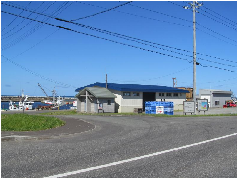
知来別 猿払村漁業協同組合 荷捌所（全景）
