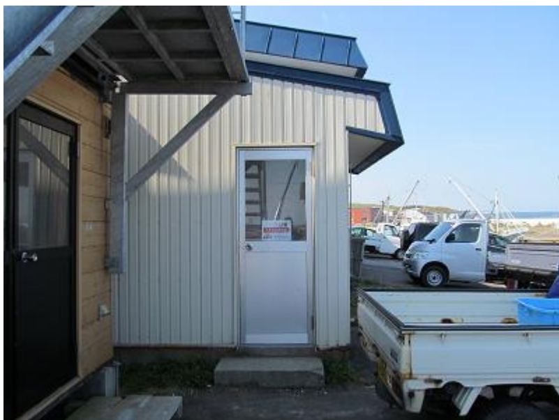
猿払村漁業協同組合 荷捌所 正面玄関
