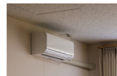
保育所乳幼児室空調設備設置 660,000円
