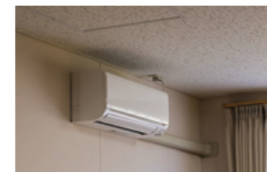
保育所乳幼児室空調設備設置 660,000円
