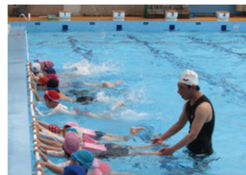
劣化の進行により今年度から休止となる村営プール
