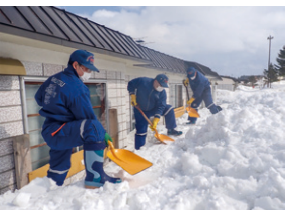
▲除雪作業の様子
