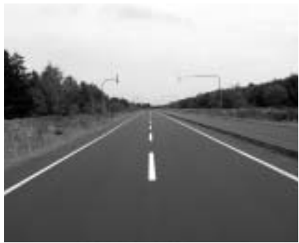
鬼志別側から見た道道 平成20年10月10日撮影
