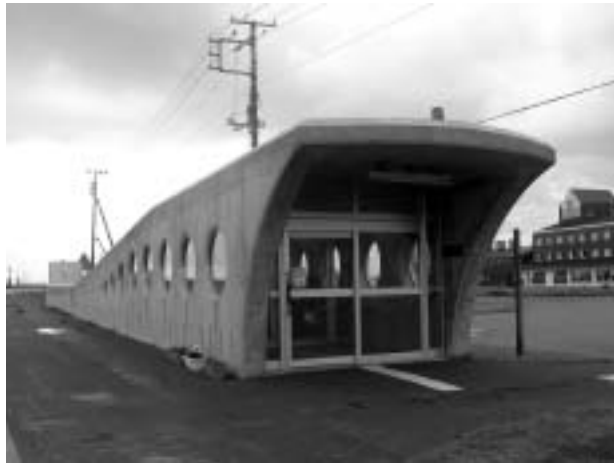
写真：さるふつ公園地下歩道の外観
